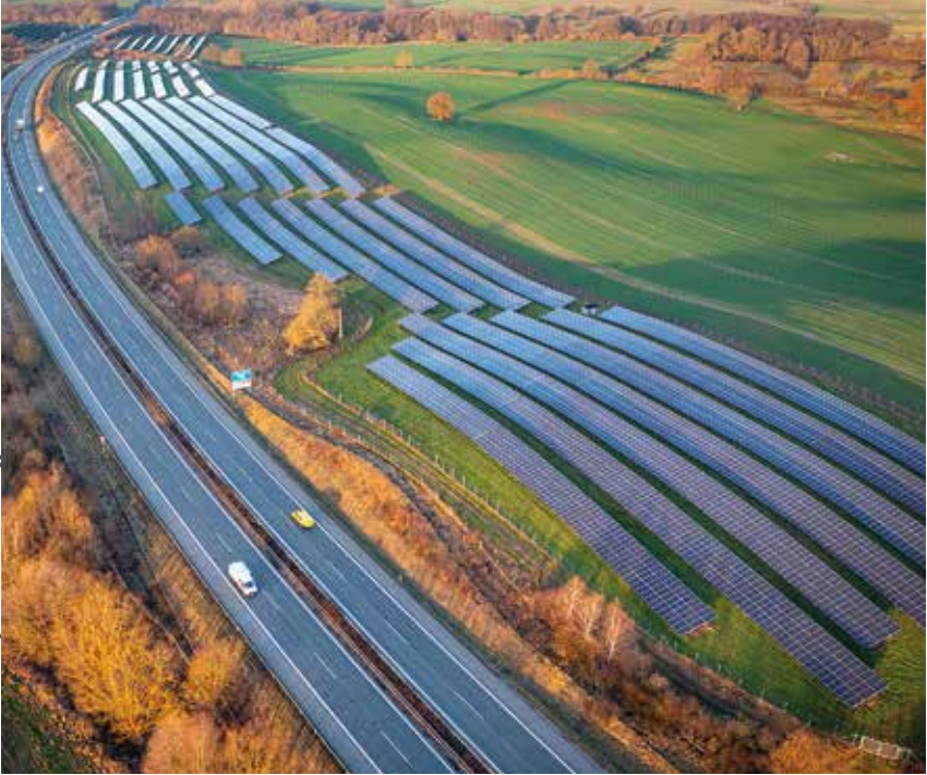
Freiflächen-PV entlang der Autobahn – Foto: karegg/Adobe Stock
